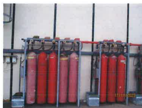
Fire Extinguisher ชนิด Carbon Dioxide
