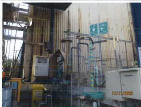
รูปที่ 3-26 อ่างล้างตาและร่างกายฉุกเฉิน
