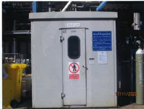
รูปที่ 3-1 CEMS ของโรงไฟฟ้า
